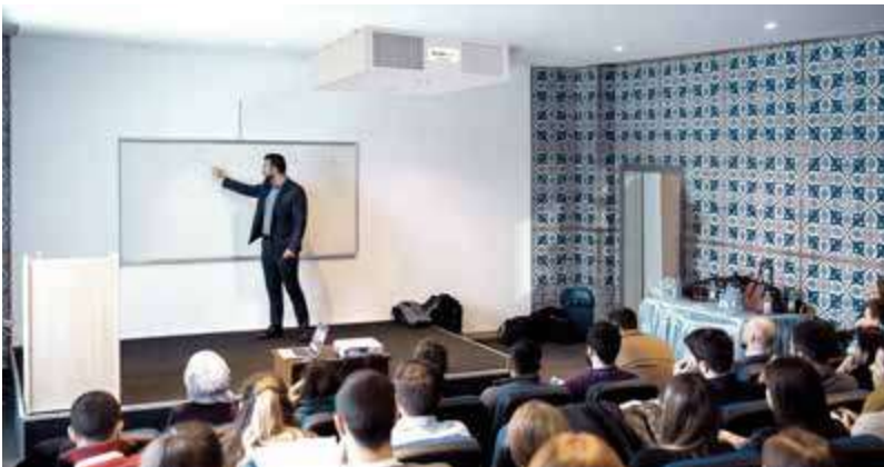
VMCS600/VMCS1200 Deckenmontage im Schulungsraum. Die Wahl der Wohneinheit richtet sich nach der maximalen Anzahl der Bewohner. VMCS600/VMCS1200 ceiling installation in a training room. The choice of the model will be based on the maximum number of occupants.
