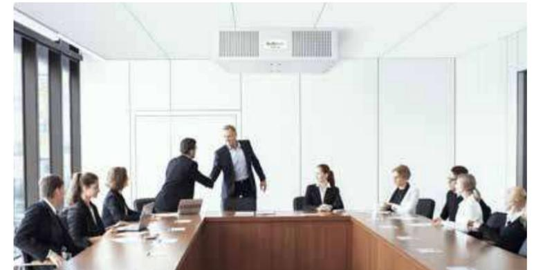
Installazione VMCS600/VMCS1200 a soffitto in sala corsi. La scelta dell'unità verrà fatta in base al numero max di occupanti.
