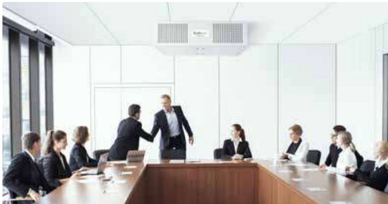
Instalación VMCS600 / VMCS1200 en el techo de la sala de reuniones. La elección de la unidad se hará en función del número máximo de ocupantes. VMCS600/VMCS1200 ceiling installation in a meeting room. The choice of the model will be based on the maximum number of occupants.
