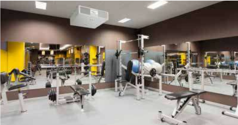
VMCS600/VMCS1200 montaj la tavan într-o sală de fitness. Alegerea modelului se va face în funcție de numărul maxim de ocupanți VMCS600/VMCS1200 ceiling installation in a gym room. The choice of the model will be based on the maximum number of occupants.
