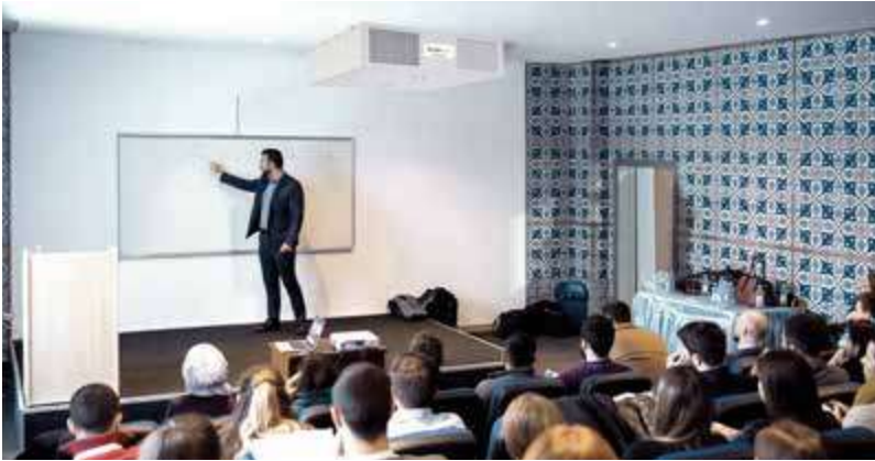
VMCS600/VMCS1200 montaj la tavan într-o sală de training. Alegerea modelului se va face în funcție de numărul maxim de ocupanți VMCS600/VMCS1200 ceiling installation in a training room. The choice of the model will be based on the maximum number of occupants.
